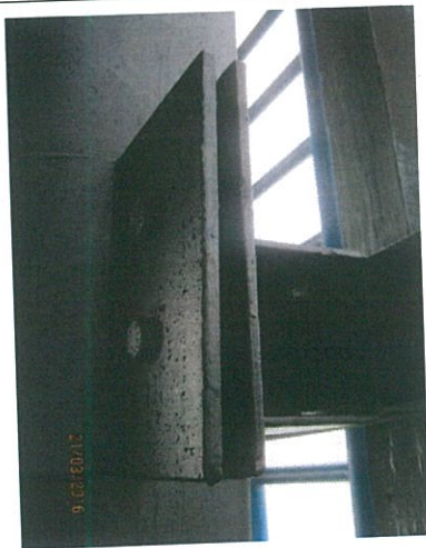
Fotografía N° 15 – 21/03/2016: Abrazadera no se ajusta a proyecto.
