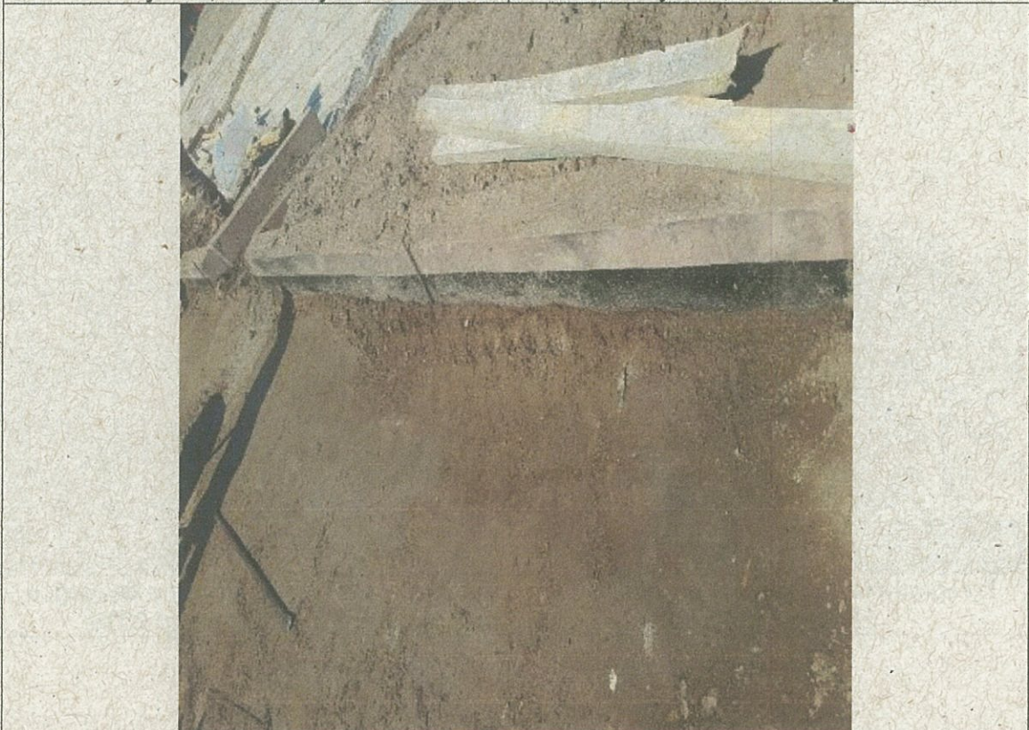
Fotografía N° 17, murete entre vértices 108 y 109, 5 de mayo 2016.
