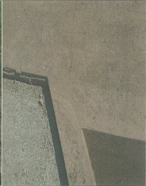
Fotografía N° 19, murete en vértice 10, 25 de mayo 2016.
