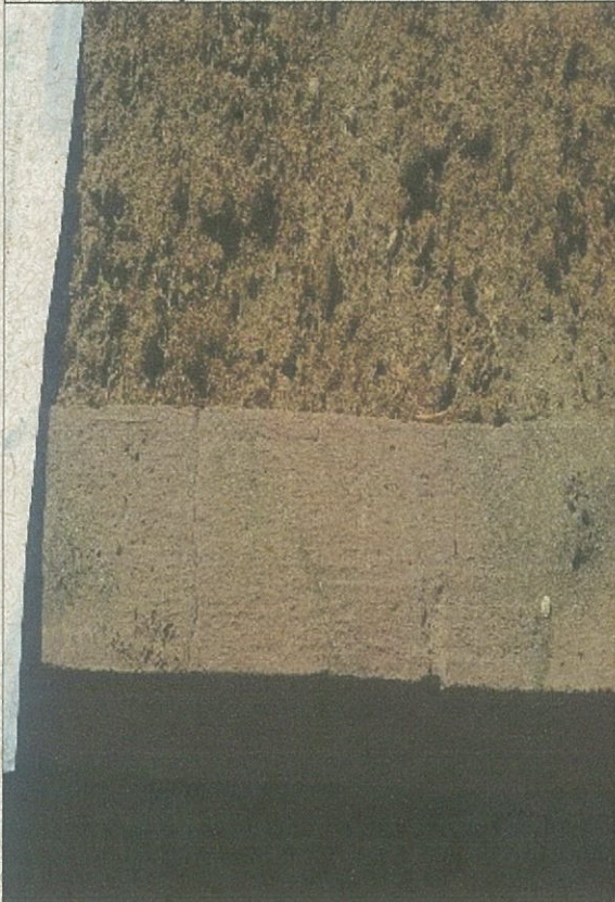
Fotografía N° 5, murete tipo 2, entre vértices 113 y 114, 28 de abril 2016.
