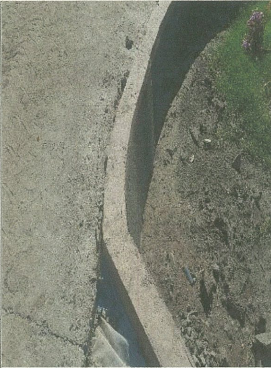
Fotografía N° 18, murete en vértice 13, 25 de mayo 2016.
