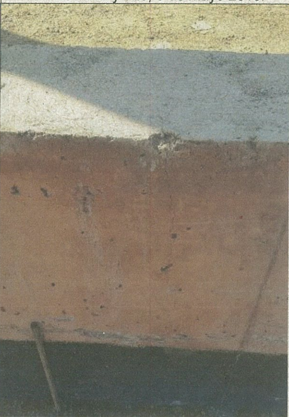
Fotografía N° 10, muro tipo 2, entre vértices 46 y 47, 25 de mayo 2016.
