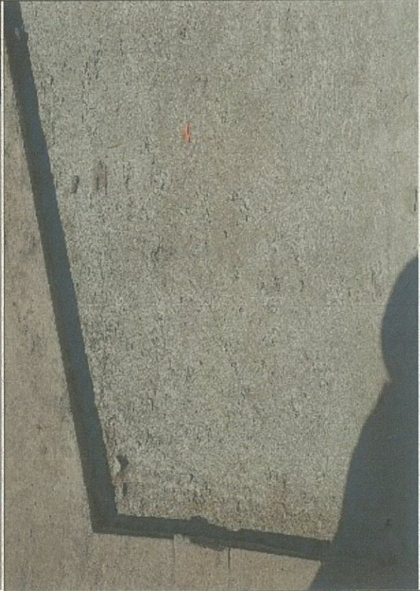
Fotografía N° 12, radier entre vértices 8 y 19, 25 de mayo 2016.
