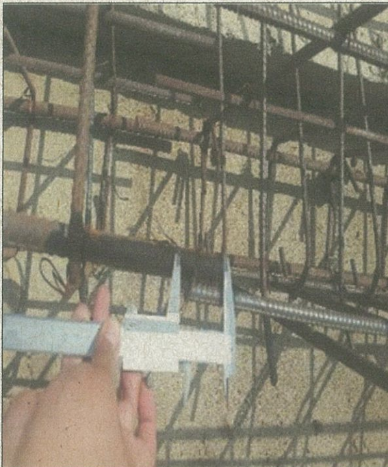
Fotografía N° 45, empalme entre barras, 5 de mayo 2016.
