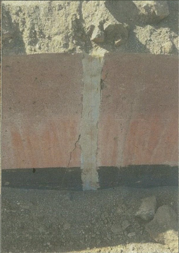
Fotografía N° 6, murete tipo 2, entre vértices 114 y 115, 28 de abril 2016.
