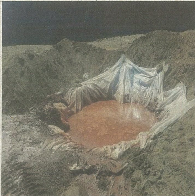
Fotografía N° 55, piscina de lavado de camiones mixer, 25 de mayo 2016.
