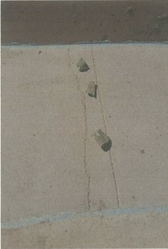
Fotografía N° 11, rampa de salida anfiteatro, 5 de mayo 2016.
