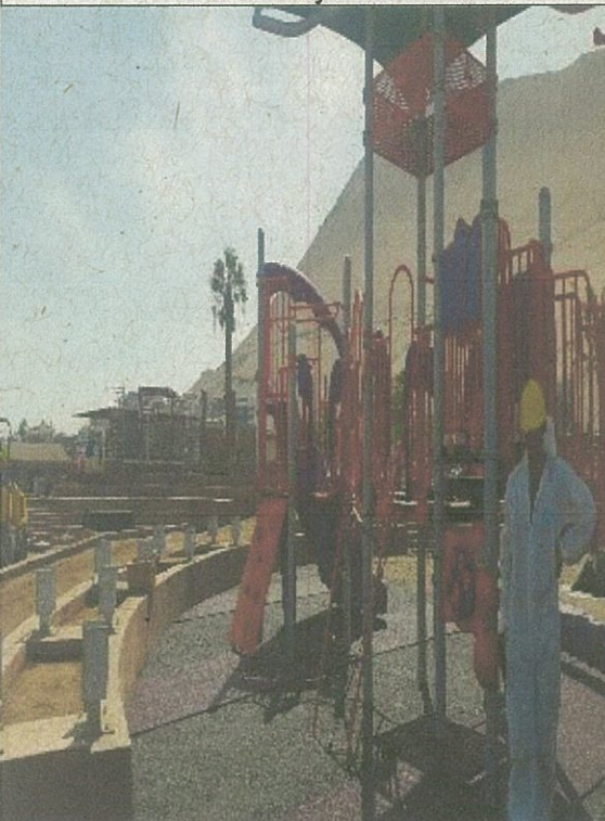
Fotografía N° 20, murete en vértice 11, 25 de mayo 2016.
