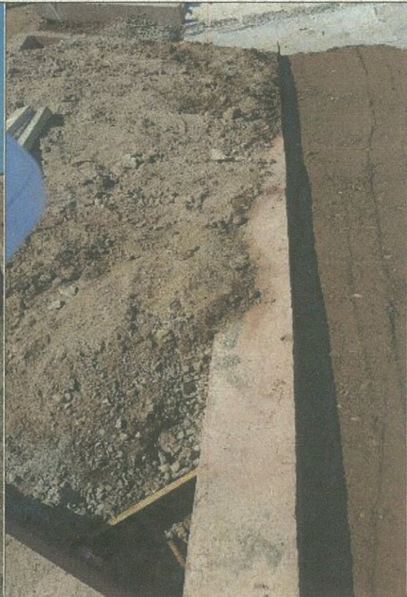
Fotografía N° 16, murete entre vértices 106 y 107, 5 de mayo 2016.
