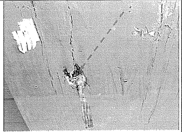
Fotografía N° 16: Madera laminada en proceso de descomposición. "Conservación muelle Anahuac"
