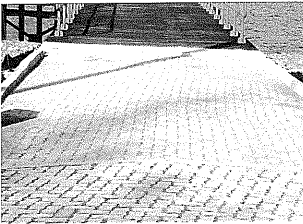
Fotografía N° 29: Deformación importante en la explanada de adocretos.
