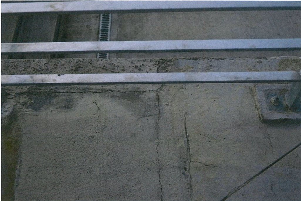
Fotografía N° 25: Fisuras en el pavimento.
