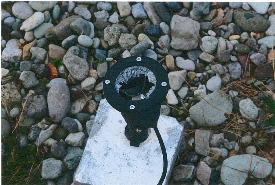
Fotografía N° 29: Luminarias en mal estado.
