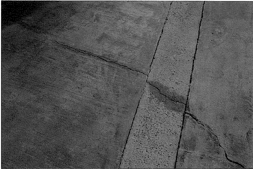
Fotografía N° 23: Fisuras en el pavimento.
