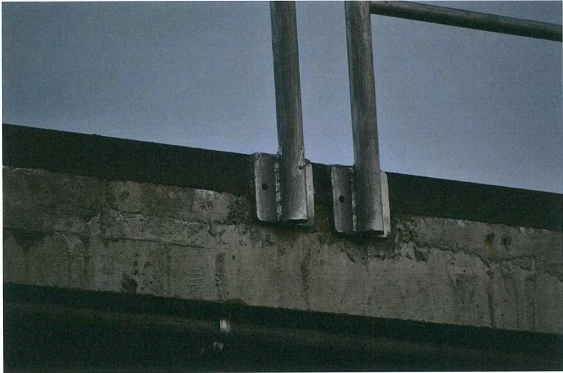
Fotografía N° 13: Uniones de Barandas peatonales soldadas a la cantonera.
