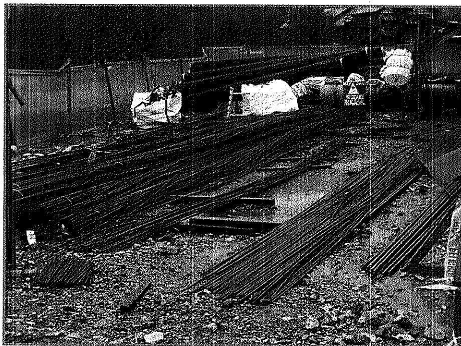
Foto N° 10. Barras de acero a la intemperie
